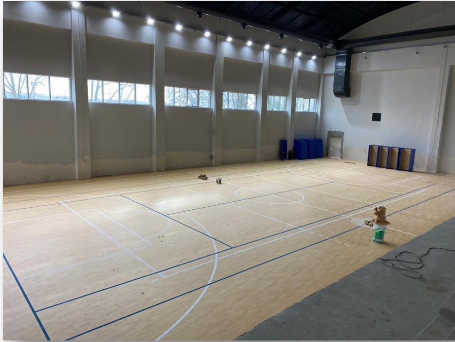
Görseller: Hamidiye Kapalı Spor Salonu İkmal İnşaatı Yapım İşi
