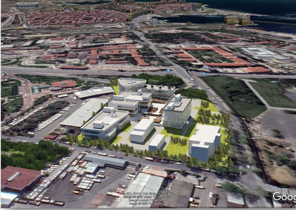
Görsel: Selimiye-Üsküdar Bölgesine Yapılacak Olan İstanbul İl Afet Risk Azaltma Planı (İRAP) Tanımlı Hamidiye Deprem Dönüşüm Binaları
